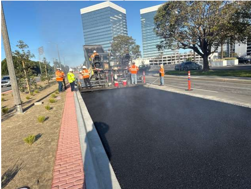
Pavement asphalt overlay on El Segundo Blvd
